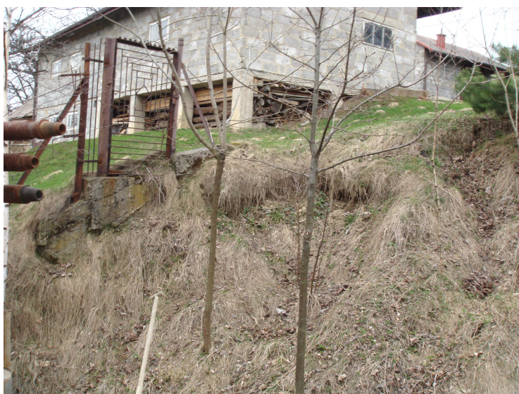
Fot.5 Skarpa osuwiskowa poniżej zabudowań gospodarczych posesji nr 48
